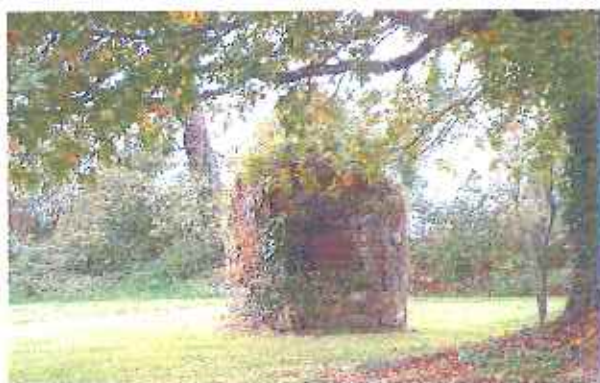
Conservation d'un ancien puits (Trévourec)
