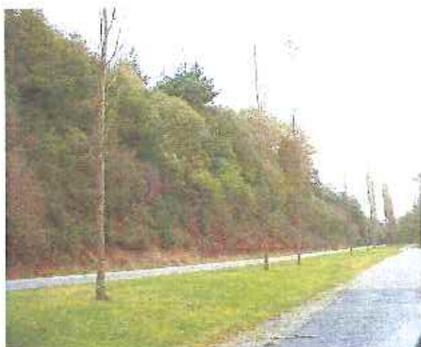
RD 769 aux accotements boisés (direction Nord-Sud)
