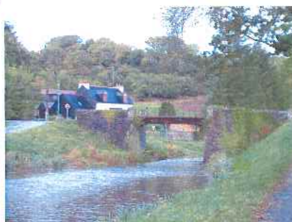
Pont de Kervoulidic vu depuis Motreff en direction de Carhaix-Plouguer
