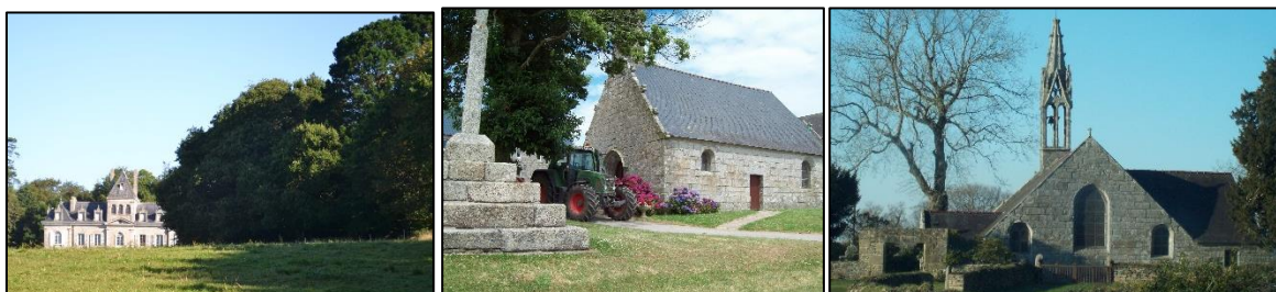
Un patrimoine architectural rural de qualité
