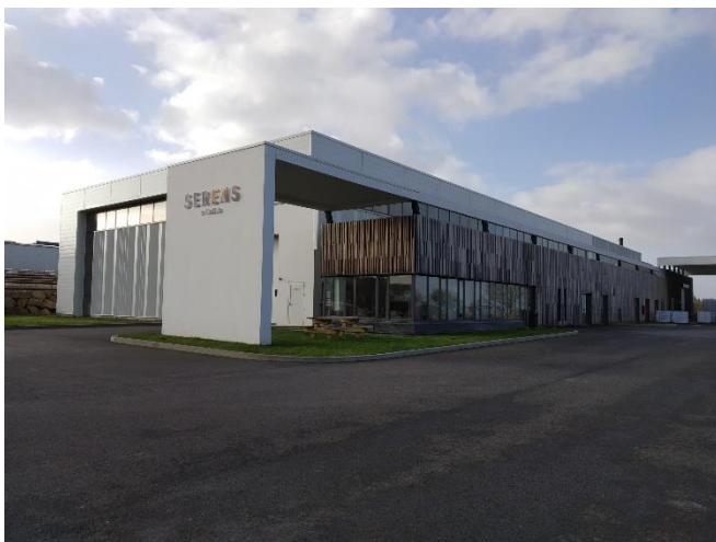
c - Vue sur le nouveau bâtiment de thermo-laquage (bâtiment 12), réalisé sur la parcelle D611
