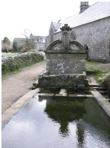
LAVOIR DE BONNE NOUVELLE
