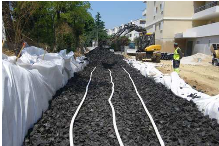
Figure 29 : exemple de dispositif d'infiltration des eaux pluviales
