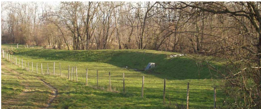
Figure 34 : exemple de bassin de rétention sec
