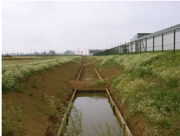
Figure 30 : exemple d'infiltration des eaux dans des noues et dans un puits d'infiltration
