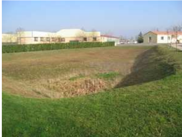
Figure 32 : bassin de rétention en forme de noue
