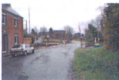
Passage à niveau
