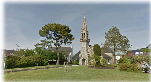
Eglise de Gouesnac'h
