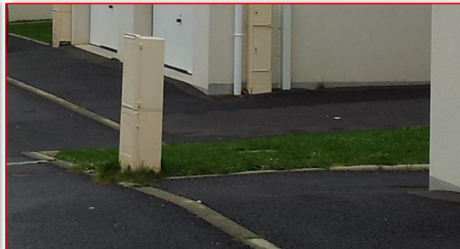
Coffrets isolés risquant d'être percutés par un véhicule
