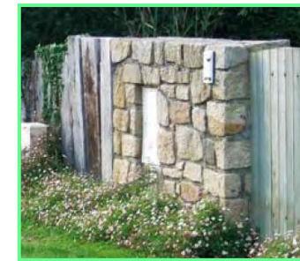
Coffrets isolés risquant d'être percutés par un véhicule
