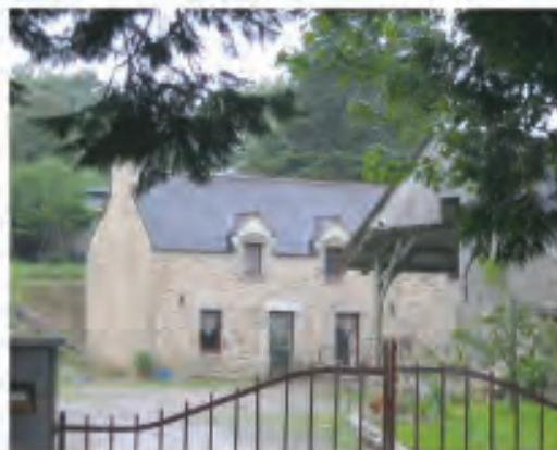
Ancien bâti rénové
