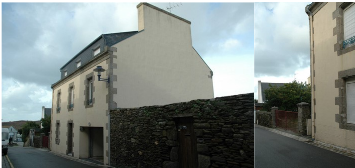
n°9b Bâtiment d'accompagnement
