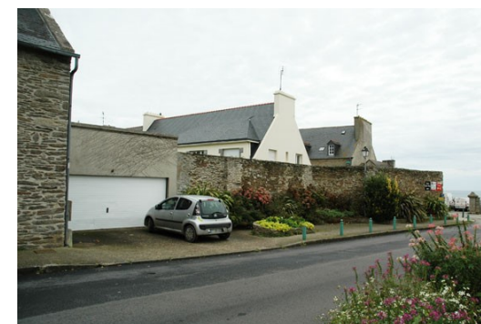
n° 24 Mur de clôture n°21 de la rue du Lieutenant Jourden
