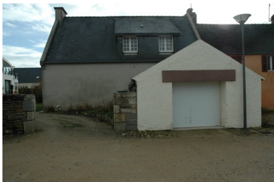
n°6 Bâtiment en rupture avec son environnement
