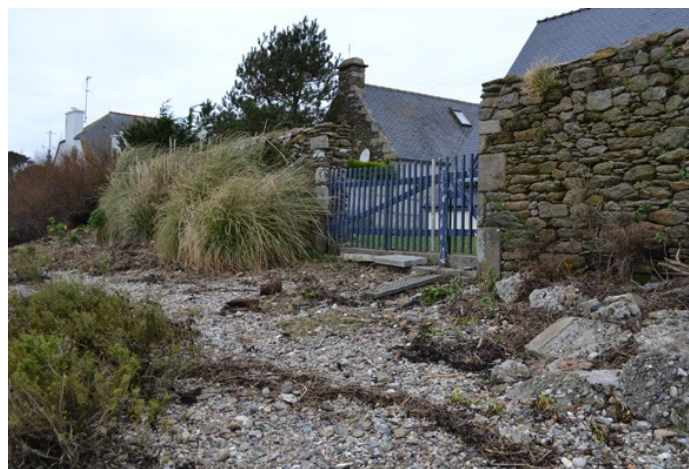
Parcelle n°685 Bâtiment d'accompagnement
