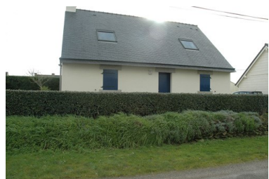
Bâtiments sans enjeu patrimonial
