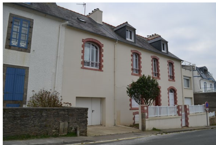
n° 24 Bâtiment accompagnement
