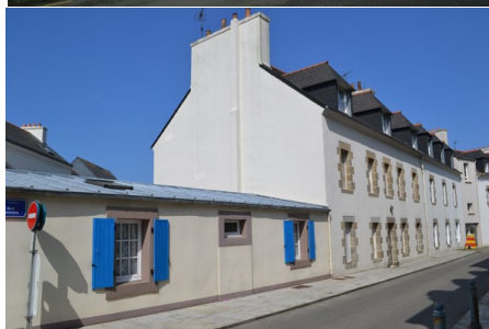
n°31 Façade arrière
