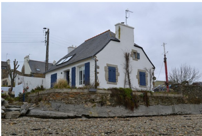
n°2 Chemin de la passerelle Bâtiment d'accompagnement
