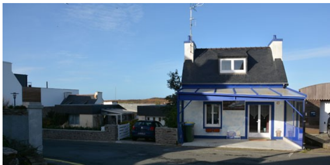
n°9 Bâtiment en rupture avec son environnement
