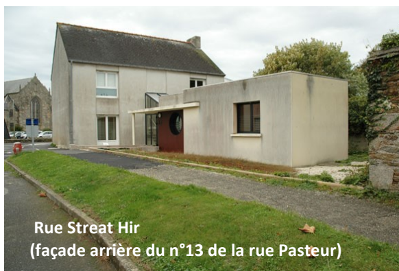
n° 13 Bâtiment en rupture avec son environnement
