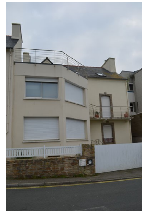
n°26 Bâtiment en rupture avec son environnement
