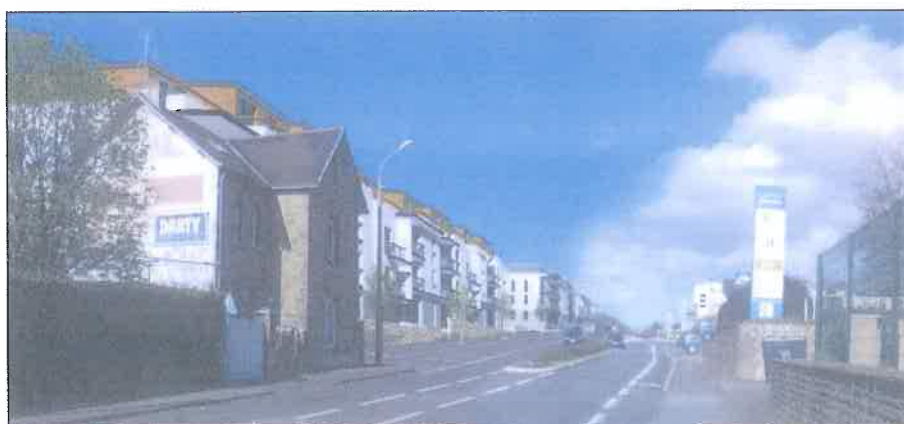
Vue depuis le bas de l'avenue de la gare avec sur la gauche les nouveaux bâtiments
