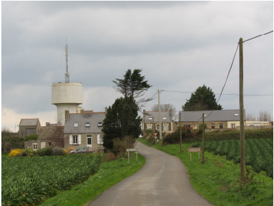
Lieu dit de Créac'h ar Vrenn
