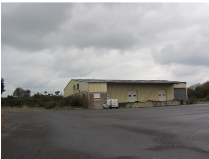
Bâtiment de stockage au sud-ouest de la zone
