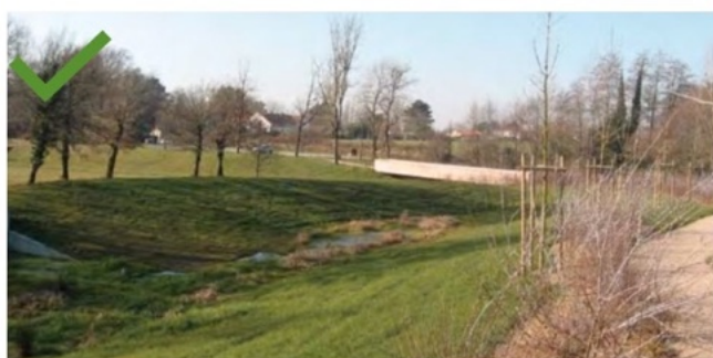
mobiliser les espaces d'agrément à faible pente comme zone tampon pour les eaux de pluie est un moyen d'allier l'utile et l'agréable
