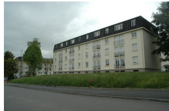
Des opérations de bâtis collectifs d'ensemble
