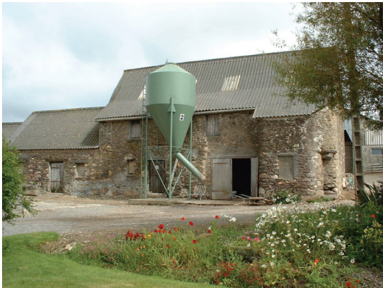
Un patrimoine bâti à protéger et mettre en valeur : le manoir du Quinquis (16 ème siècle) sert d'annexe agricole
