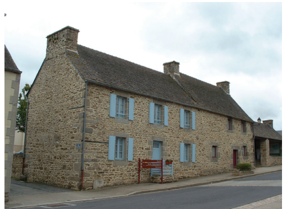
Un exemple à suivre : les réhabilitations très réussies du centre bourg
