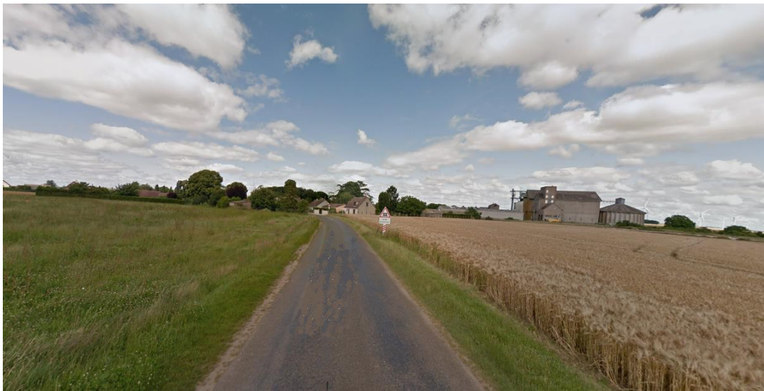
Le silo se détache de la silhouette du village.
