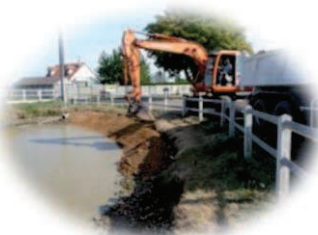
Travaux, mare de Chauffours (Cen Centre)
