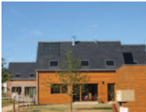
panneau solaire intégré à la toiture
