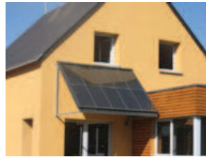
panneau solaire non intégré à la toiture
