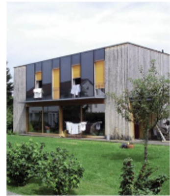
Les capteurs posés verticalement participent pleinement de la composition de la façade. Maison individuelle à Wolfurt (Vorarlberg, Autriche) © CAUE 78
