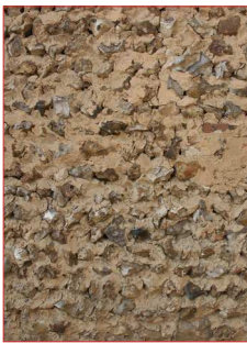
Maçonnerie de silex
