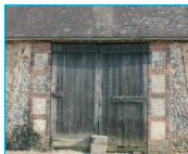
Tuiles en terre cuite, silex, bauge, briques en terre cuite, hêtre pour la porte de la grange. Saint-Jean de Rebervilliers.
