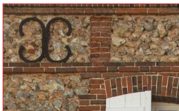
Maçonnerie de brique et silex.
