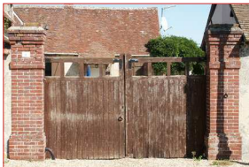
Portail avec piliers en brique. Tremblay-les-Villages
