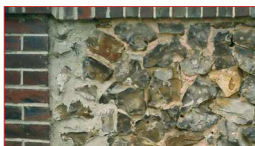
Maçonnerie de brique et silex.
