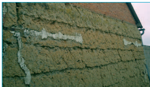
Mur en bauge. Broué.
