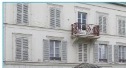
Moulurations dans un enduit plâtre et chaux. Anet.
