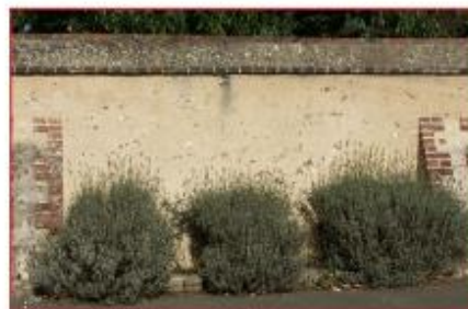
Mur de clôture en bauge avec chaperon maçonné et contreforts en brique. Escarpain
