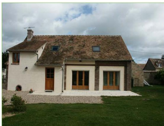
En dessous : la grange réaménagée en gîte au printemps 2007.
