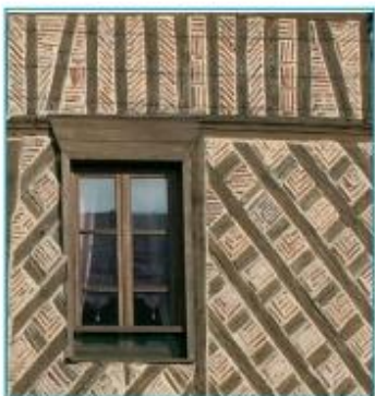
Différents assemblages à Châteauneuf-en-Thymerrais : brique, brique et silex, briquettes et pan de bois...
