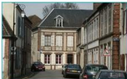
Maisons en maçonnerie de moellons enduite et brique appareillée. Brezailles.
