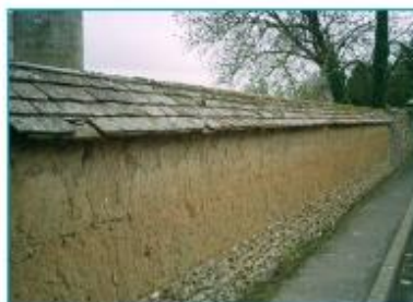
Mur en terre crue, soubassement silex. Broué.
