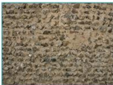
Le soubassement des murs en bauge : rognons de silex et mortier de terre crue. Laons.
