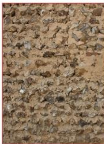
Maçonnerie de silex
