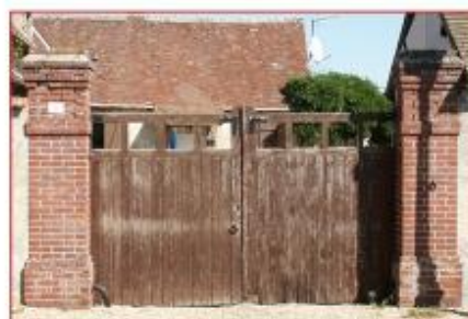
Portail avec piliers en brique. Tremblay-les-Villages
