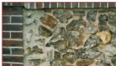
Maçonnerie de brique et silex
