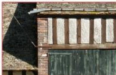
Colombages protégés par un lait de chaux
