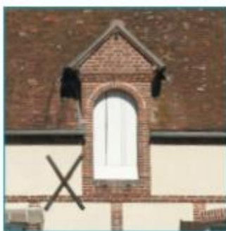
Lucarne engagée dans le mur (dite pendante), maçonnée, en bâtière.
