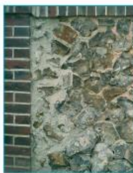
Mur en silex et chaîne en brique.
