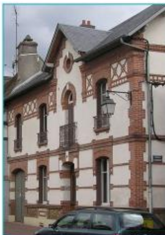
Maison en maçonnerie enduite et modénature en brique appareillée. Anet.
