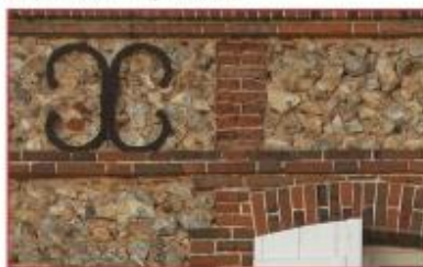
Maçonnerie de brique et silex
