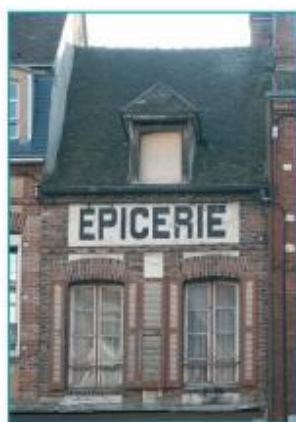
Différents assemblages à Châteauneuf-en-Thymerrais : brique, brique et silex, briquettes et pan de bois...
