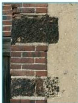
Maçonnerie en pierre de grison et brique.
