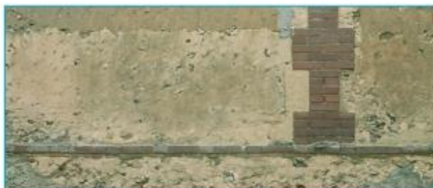
Mur en bauge recouvert d'un badigeon de chaux. Broué.
