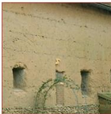
Mur de ferme et en haut à droite mur de clôture en bauge.
