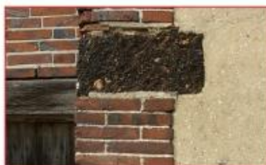
Maçonnerie de brique et grison et moellons enduits
