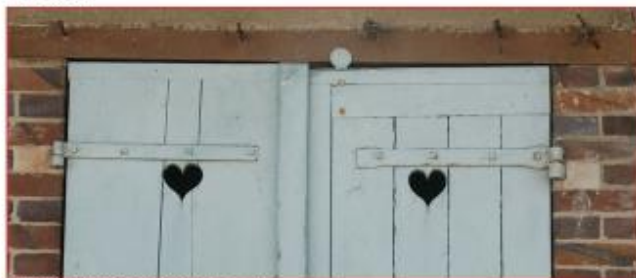
Jour de ventilation en forme de cœur
