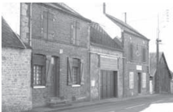
Avant : baie dénaturée (partiellement remplie en parpaings).
