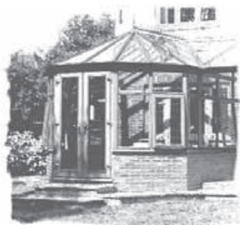
Véranda aux murs et toit vitrés, à éviter en raison de l'effet de serre.
