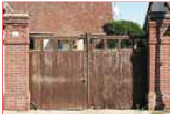
Portail avec piliers en brique. Tremblay-les-Villages.
