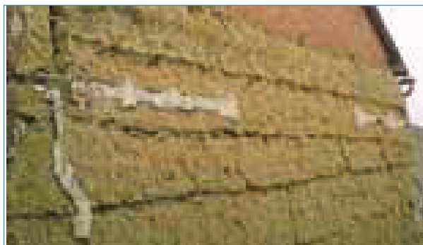
Mur en bauge. Broué.
