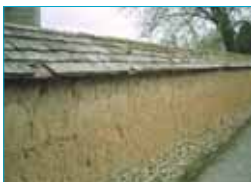
Mur en terre crue, soubassement silex. Broué.
