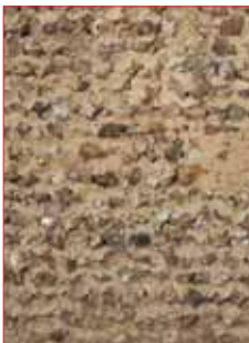
Maçonnerie en silex.
