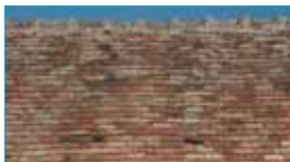
Le faitage des toitures en tuile.
