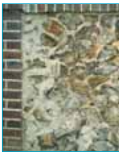
Mur en silex et chaîne en brique.
