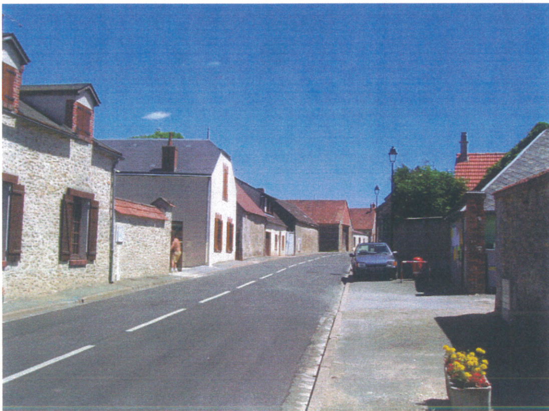
Traverse du bourg de ROINVILLE SOUS AUNEAU
