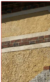
Enduit couvrant ocre-jaune et brique.
