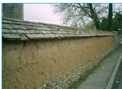
Mur en terre crue, soubassement silex. Broué.
