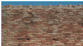
Le faitage des toitures en tuile
