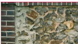
Maçonnerie de brique et silex.
