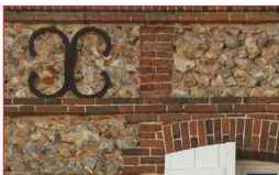
Maçonnerie de brique et silex.
