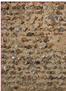
Maçonnerie de silex
