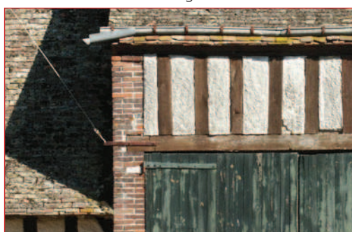
Colombages protégés par un lait de chaux.
