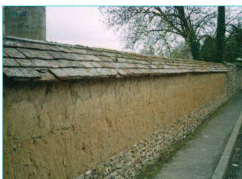
Mur en terre crue, soubassement silex. Broué.
