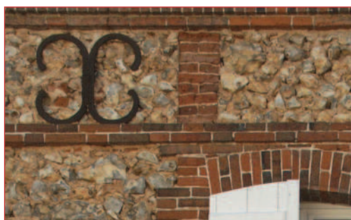
Maçonnerie de brique et silex.
