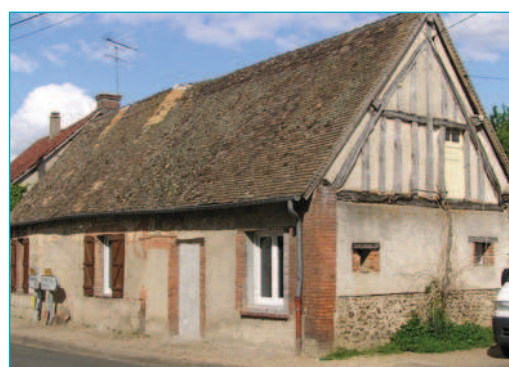
Colombage et remplissage torchis, maçonnerie enduite, silex et brique. Abondant
