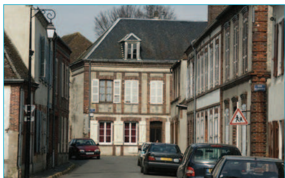
Maisons en maçonnerie de moellons enduite et brique appareillée. Brezolles.
