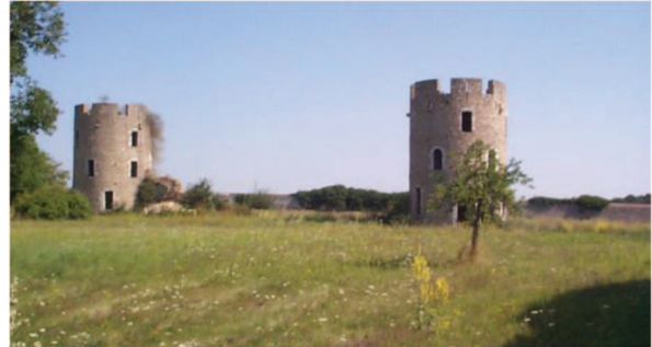
Les deux tourelles reconstituées du Château de Prémont
