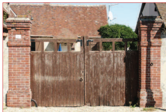
Portail avec piliers en brique. Tremblay-les-Villages
