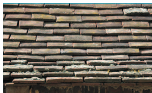
Toit débordant en tuile
