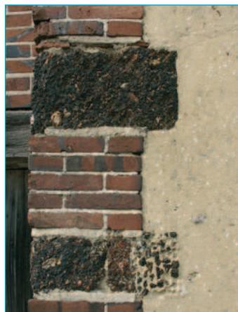
Maçonnerie en pierre de grison et brique.
