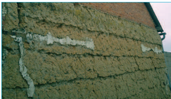
Mur en bauge. Broué.
