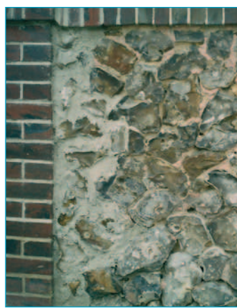
Mur en silex et chaîne en brique.
