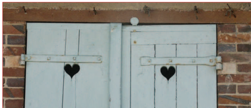
Jour de ventilation en forme de cœur
