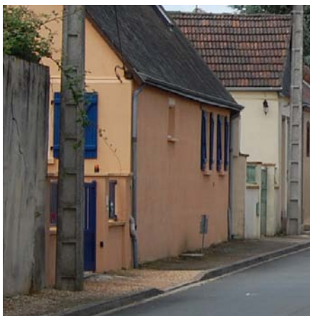
Concordance entre le portail et les volets (couleur), entre la façade et le mur bahut (traitement).
