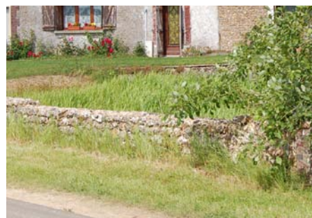
muret en pierres
