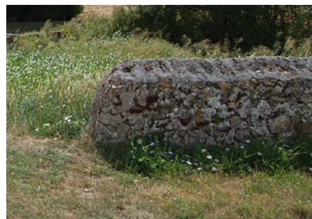
muret en moellon
