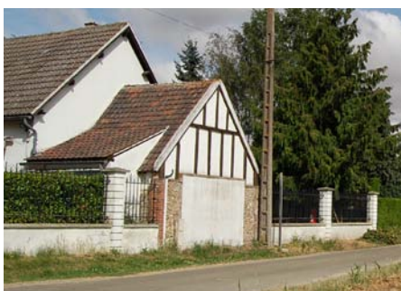
bahut enduit / grille en fer disparaissant sous la végétation
