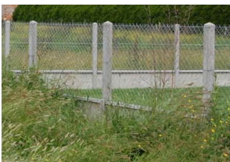
Clôture commune : bahut en plaque de béton, piquet béton et grillage
