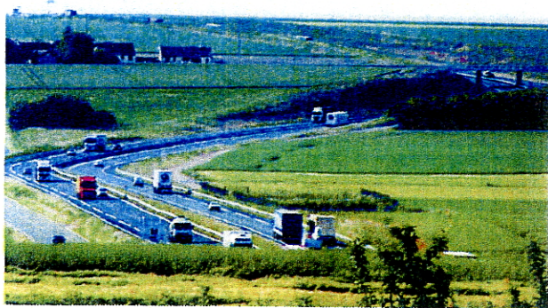
RN 154 entre Chartres et Dreux : une entaille dans le paysage qui interdit toute transversalité future et empêche toute mise en valeur du territoire. Le tracé doit suivre le terrain naturel (développement durable) même si cela implique la création de murs anti-bruit par endroits.
