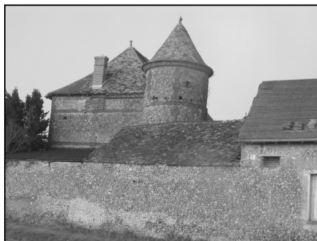
Mur de clôture et bâtiment
