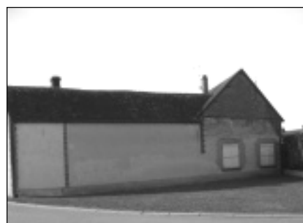
Le bâtiment de la future salle communale
