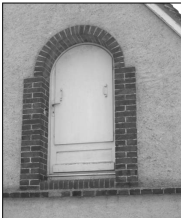
Ouverture dans le pignon, servant d'accès au grenier.
