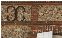
Maçonnerie de brique et silex.
