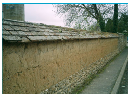
Mur en terre crue, soubassement silex. Broué.
