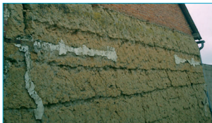
Mur en bauge. Broué.
