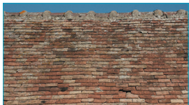
Le faitage des toitures en tuile
