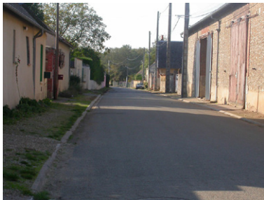
C7 Rue principale de Varennes
