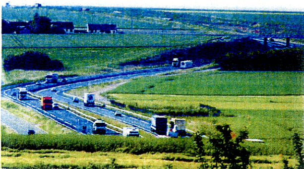
RN 154 entre Chartres et Dreux : une entaille dans le paysage qui interdit toute transversalité future et empêche toute mise en valeur du territoire. Le tracé doit suivre le terrain naturel (développement durable) même si cela implique la création de murs anti-bruit par endroits.
