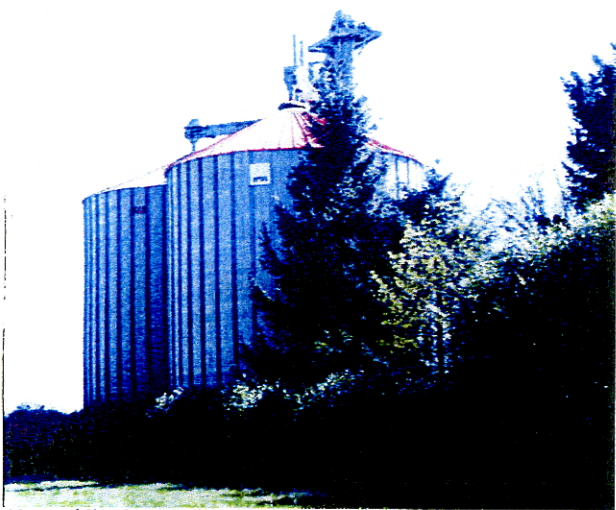
Une réflexion architecturale et paysagère est nécessaire pour tous les projets y compris les éléments techniques. Commune de Houville-la-Branche
