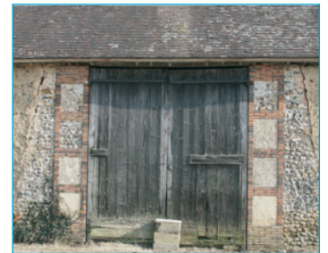
Tuiles en terre cuite, silex, bauge, briques en terre cuite, hêtre pour la porte de la grange. Saint-Jean de Rebervilliers.
