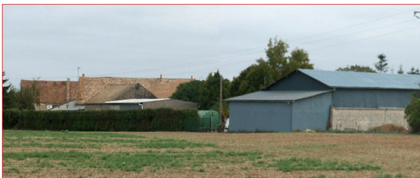
Fractionnement des volumes et couleurs mates et sombres permettent de rompre la linéarité et de diminuer l'impact des bâtiments dans le paysage.
