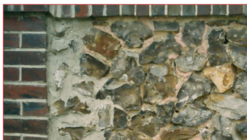
Maçonnerie de brique et silex.
