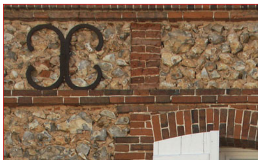
Maçonnerie de brique et silex.
