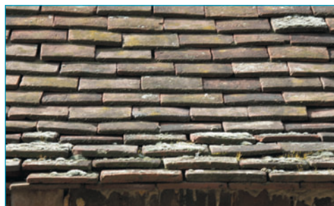
Toit débordant en tuile
