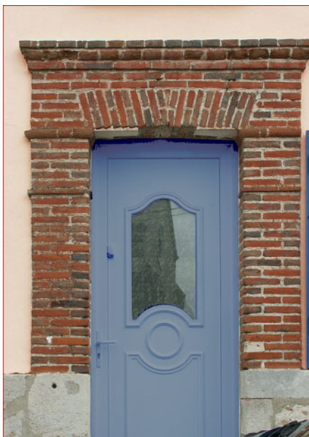
Exemple satisfaisant de l'entretien d'une maçonnerie en brique. Les couleurs et textures des nouveaux joints ou des briques remplacées sont identiques aux anciennes.
