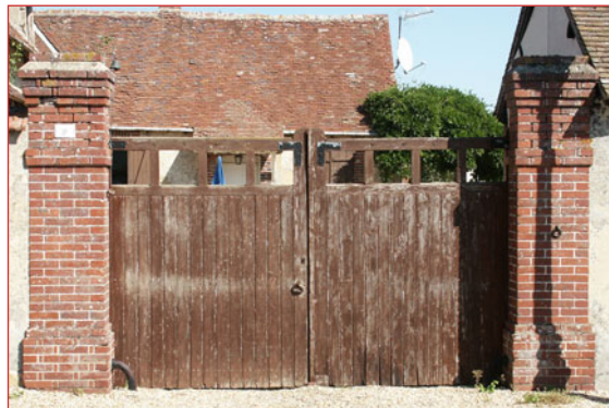
Portail avec piliers en brique. Tremblay-les-Villages
