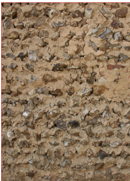
Maçonnerie de silex
