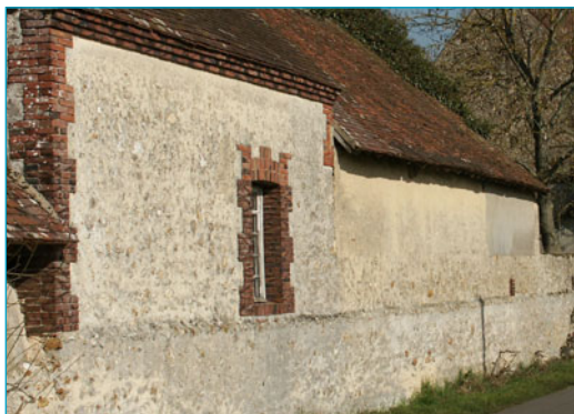
Enduit à pierre vue au premier plan de la construction, et enduit couvrant au second plan. Saint-Ange et Torçay.
