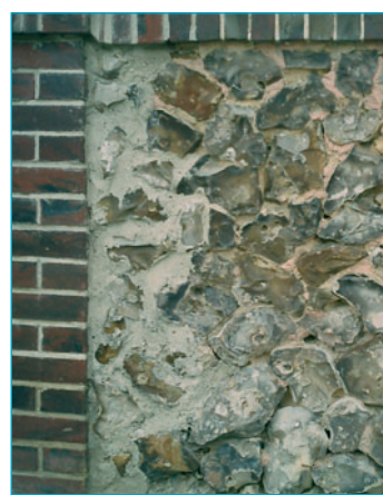
Mur en silex et chaîne en brique.
