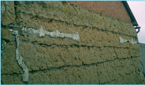
Mur en bauge. Broué.
