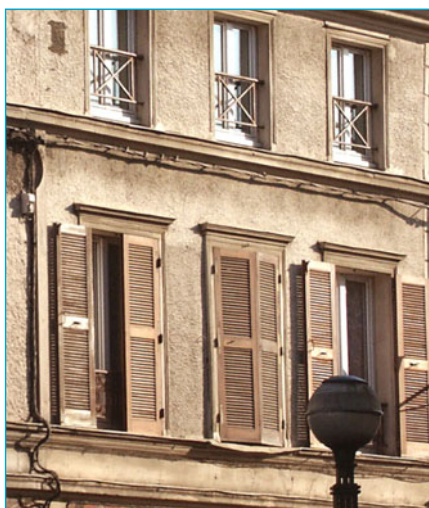
Enduit plâtre et chaux sur une ossature en pan de bois. Châteaufort-en-Thymerais.
