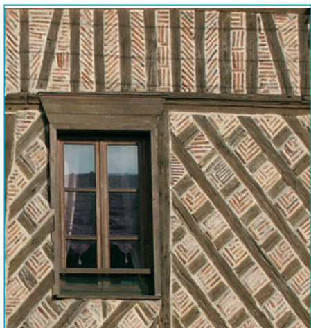
Différents assemblages à Châteauneuf-en-Thymerais : brique, brique et silex, briquettes et pan de bois...
