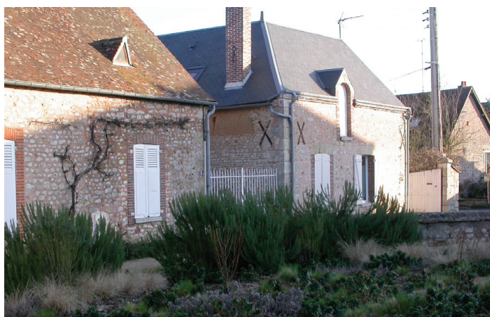
Les bâtiments traditionnels, corps de ferme, donnant sur la place
