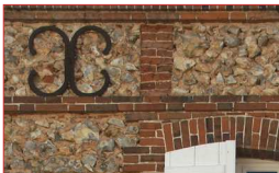
Maçonnerie de brique et silex.
