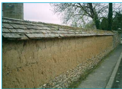
Mur en terre crue, soubassement silex. Broué.
