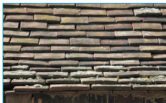
Toit débordant en tuile
