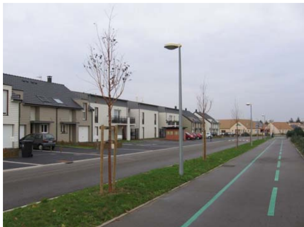
Pavillons locatifs rue de la Croix Jouvét
