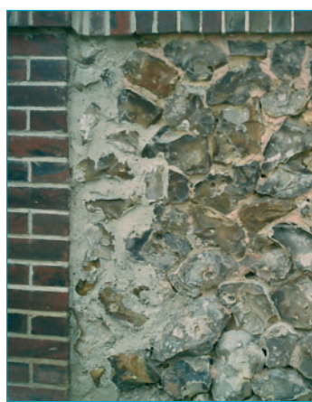
Mur en silex et chaîne en brique.
