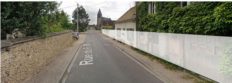
Bâtiments à l'alignement rue du Rosaire Source : Google StreetView
