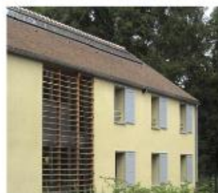
Un ensemble de capteurs thermiques souligne le faîtage de la toiture. Centre médicalisé à Buillon (Yvelines). Cabinet Méandre, architectes © PNR Haute Vallée de Chevreuse
