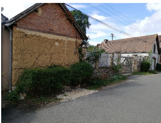
Figure 29 - pignon en bauge rue des Eternys
