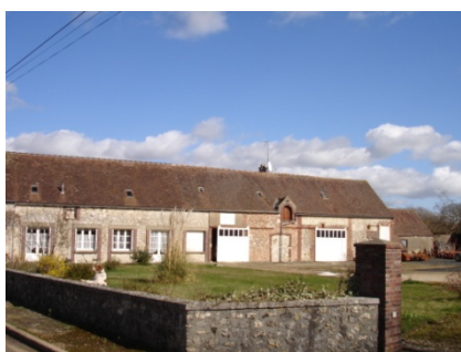
Bâtiment d'habitation de ferme et grange attenante, Boncé
