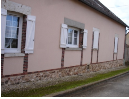
Maçonnerie mixte : soubassement de silex, chaînage en brique et linteau en pierre de taille. La brique et le silex servent également d'éléments de décors. Les murs sont de moellons enduits.
