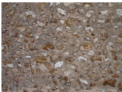
moellon de silex enduit à pierre vue.
