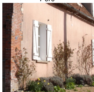
Maçonnerie enduite.
