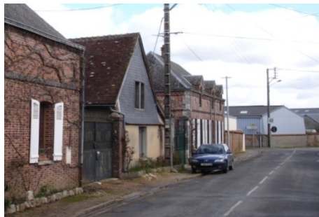
Exemples de constructions en briques, Boncé
