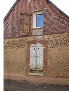
Soubassement de moellons enduits, bauge et moellons. Pignon en brique.
