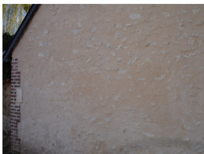
Moellon enduit à pierre vue
