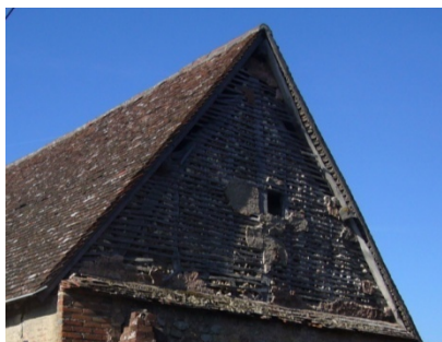
Structure de bois, remplissage de torchis Rouvray-Saint-Florentin
