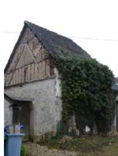
Structure du pignon en moellons et structure à pan de bois. Remplissage de torchis
