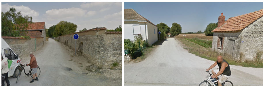
Chemin du Bois-Berlin avant travaux
