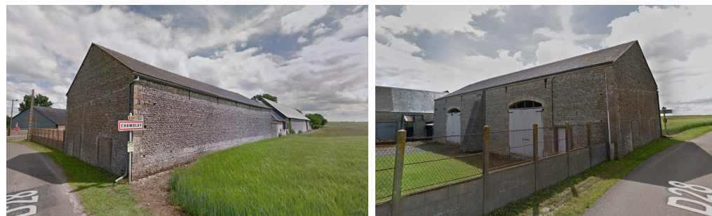
Exemple de bâti agricole et remarquable du hameau de Chamblay pouvant prétendre à un changement de destination
