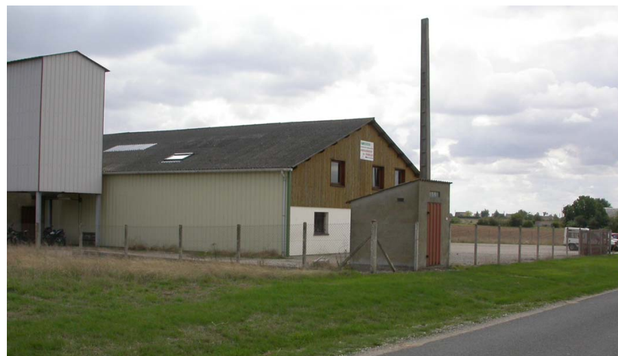
Une menuiserie industrielle est installée sur la zone d'activités le long de la RD 28 en sortie nord-est de Berchères, au lieu-dit Sermaises.
