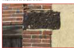
Maçonnerie de brique et grison et moellons enduits.
