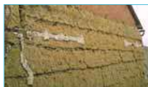
Mur en bauge. Broué.
