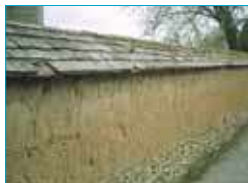
Mur en terre crue, soubassement silex. Broué.
