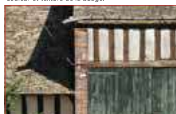
Colombages protégés par un lait de chaux.
