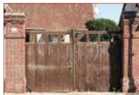
Portail avec piliers en brique. Tremblay-les-Villages.
