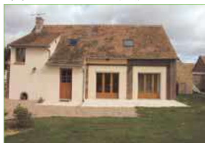
La grange réaménagée en gîte au printemps 2007.
