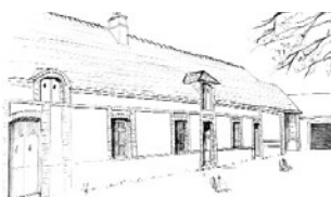
Bâtiment d'habitation d'une ferme ouverte sur la cour. Maillebois. Les volumes de ces bâtiments sont des parallélépipèdes allongés. Les travées ne sont pas forcément réparties régulièrement. Les baies sont souvent légèrement cintrées. Une lucarne engagée dans le mur, permet l'accès au grenier.
