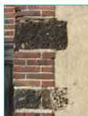
Maçonnerie en pierre de grison et brique.
