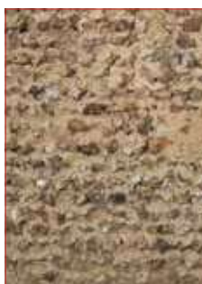
Maçonnerie en silex.
