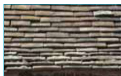
Toit débordant en tuile.
