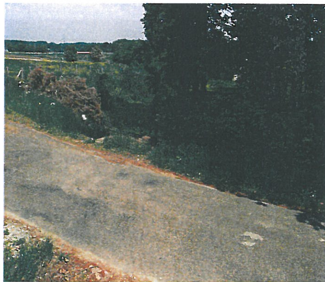
Busage du fossé sous la VC4
