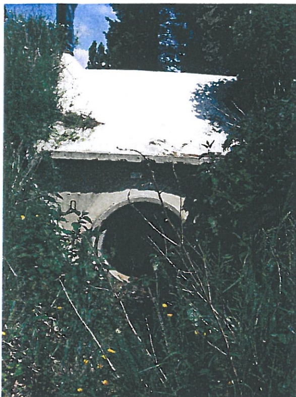
fossé de drainage
