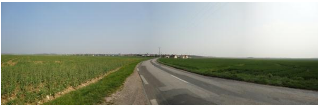
Silhouette plus minérale du bourg de Villiers-en-Désœuvre
