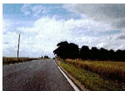
La RD 6014 en venant du Sud-Ouest
