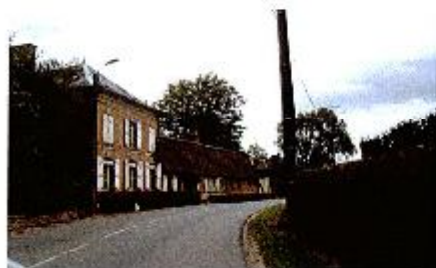
chaumières situées face à l'église
