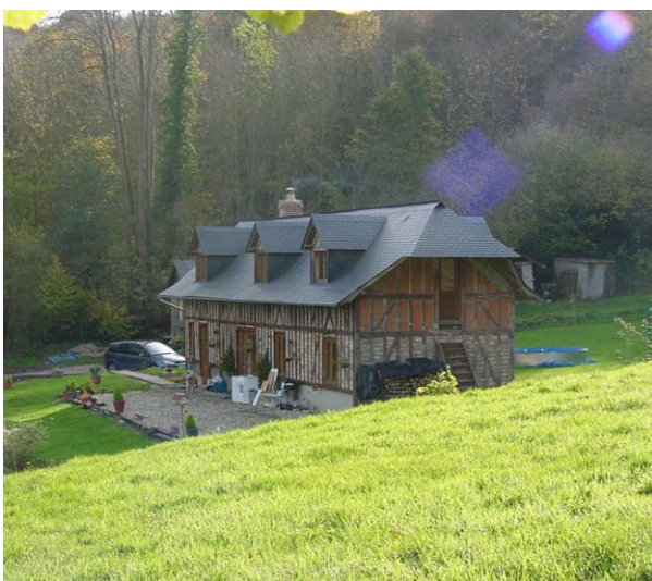
Figure 38: Construction neuve à l'extrémité du Chemin de l'Enfer du Roy
