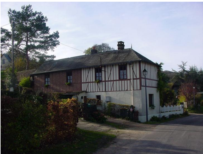
Figure 30: Demeure en briques et pans de bois implantée à l'alignement de la RD n°95 (bourg centre)
