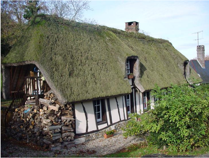
Figure 26: Chaumière authentique Chemin de l'Enfer du Roy – Lucarnes rampantes et queue de geai traditionnelle
