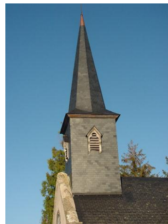
Figure 57: Toiture du clocher de l'Eglise Saint-Michel récemment restaurée
