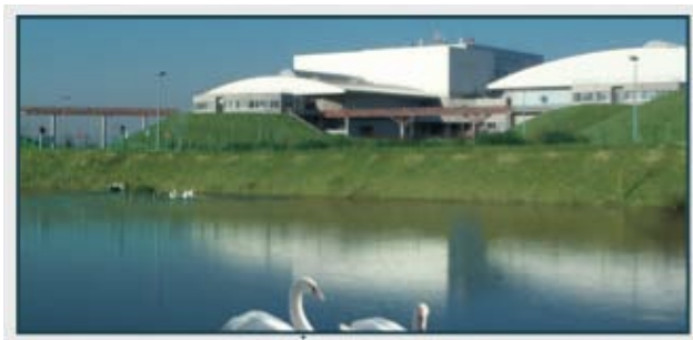
L'usine d'incinération de Guichainville
