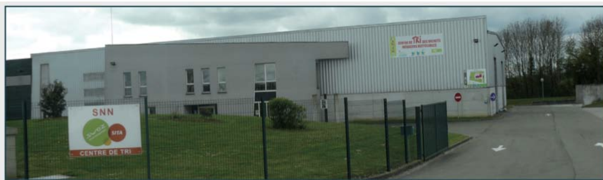
Centre de tri des déchets recyclables d'Étrépagny
