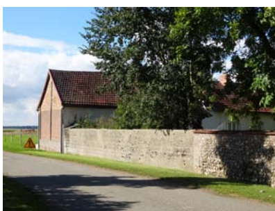
Alignement du pignon
