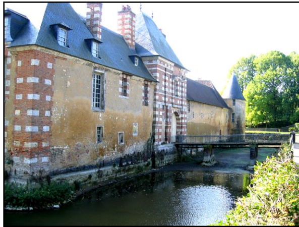
Chateau de la Fontaine du Houx, à Bézu-la-Forêt (ancien manoir des Rois de France)
