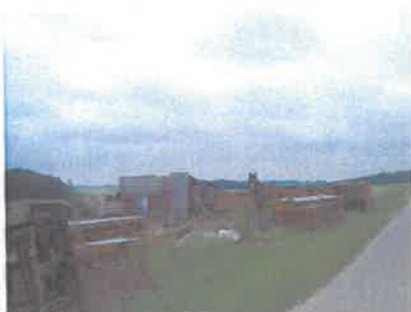
Absence de clôture de qualité
