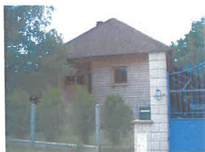
Façade en bardage bois (Boisset-Hennequin)
