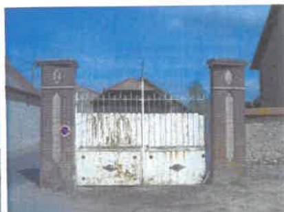
Portail peu entretenu, bâtiment d'activité
