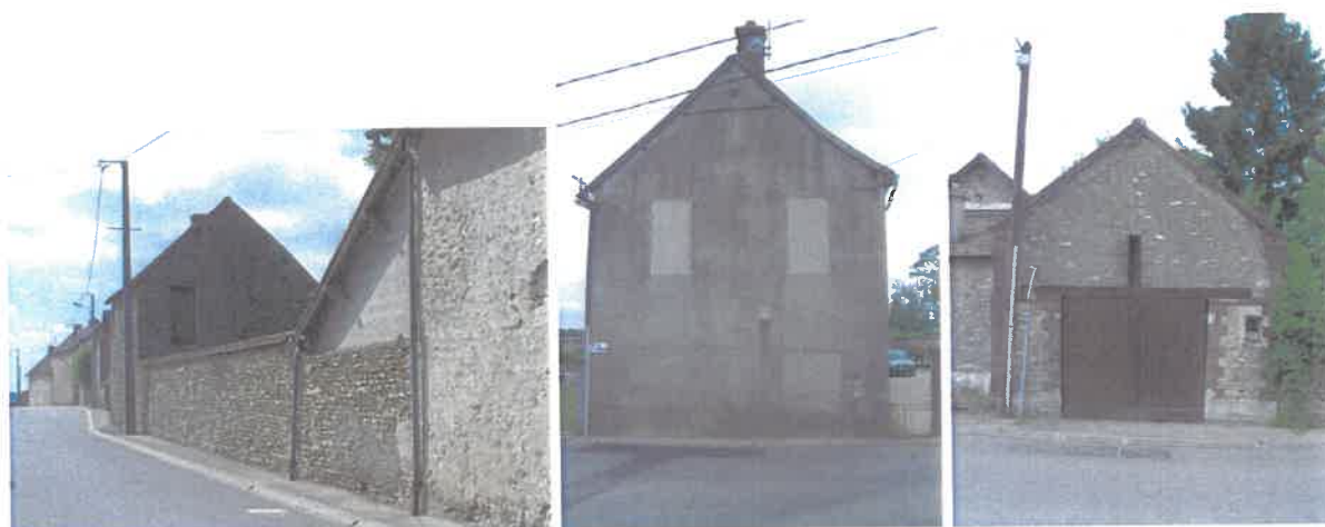
Constructions perpendiculaires à la voirie dans le centre-bourg, avec parfois des pignons apparents peu entretenus
