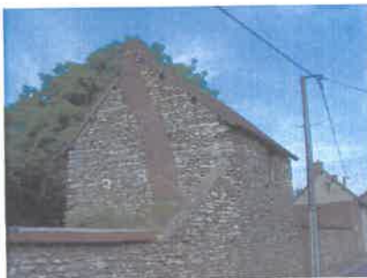
Bâtiment ancien en pierres locales
