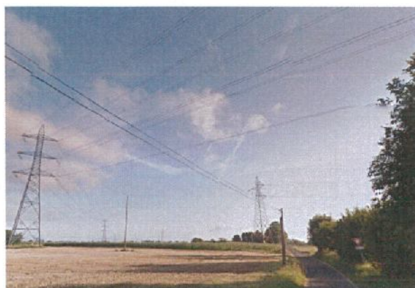
Impact des lignes électriques à très haute tension sur la partie Sud-est de la commune
