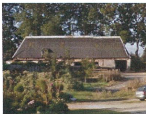
Bâtiment agricole chemin Perrey
